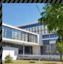
Site des Chênes Cergy (95)
