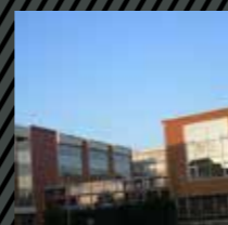
Site du Parc Cergy (95)
